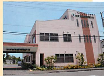
免震設計された施設を増築予定の志太記念脳神経外科
